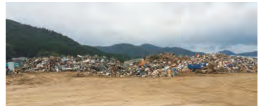
土砂・がれき処理場（丹波市内）
