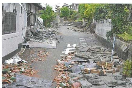
ブロック塀はいたる所で倒壊し道路に倒れ込む
