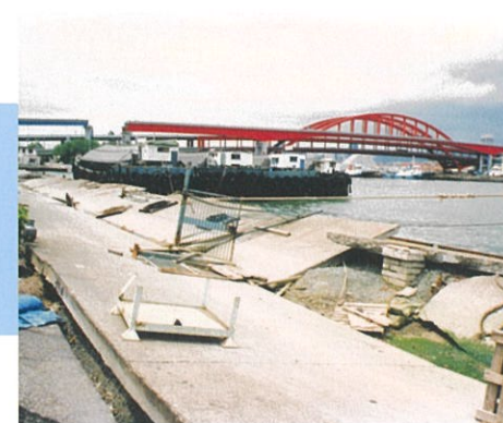
地震と液状化で割れた港 0000578-001001-001.0020
