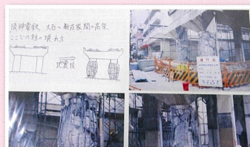
阪神電鉄大石 - 新在家間の橋脚
