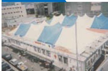
仮設店舗パラル市場竣工風景 (1995年6月/神戸市長田区)
