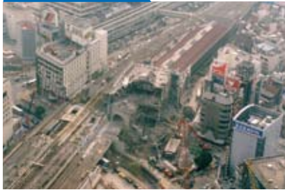
阪急三宮駅周辺の被災の様子（1995年/神戸市中央区）
