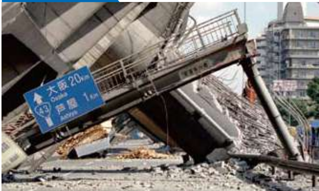
倒壊した阪神高速道路(1995年1月/神戸市東灘区)
