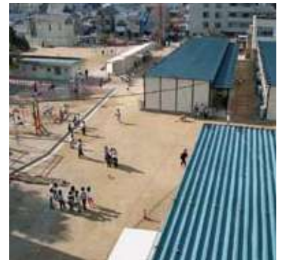
本山第二小学校仮設校舎 (1996年12月/神戸市東灘区) 写真提供:神戸市
