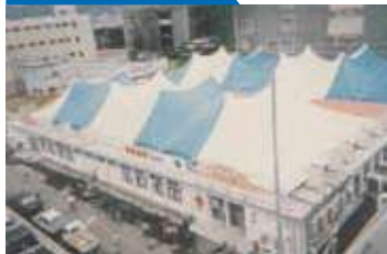
仮設店舗パラール市場竣工風景 (1995年6月/神戸市長田区)
