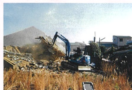
砂埃をあげながら解体される自宅 (0000625-001-001.016)
