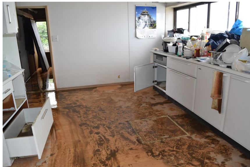
被災した技能実習生の寮の様子
