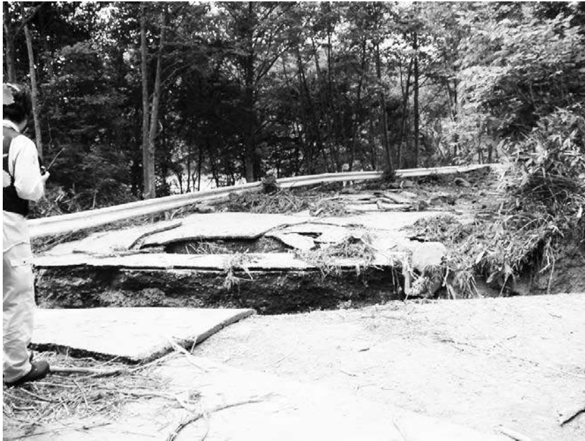
写真 1 荒砥沢ダム沿岸道路被害
