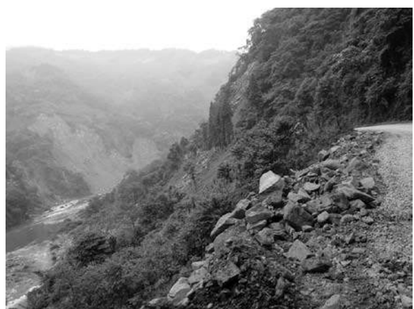
写真2 地震によって発生した土砂災害 (2008年5月27日、矢守撮影)
