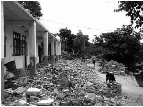
二階が崩れ、一階部分に瓦礫が散乱している。
