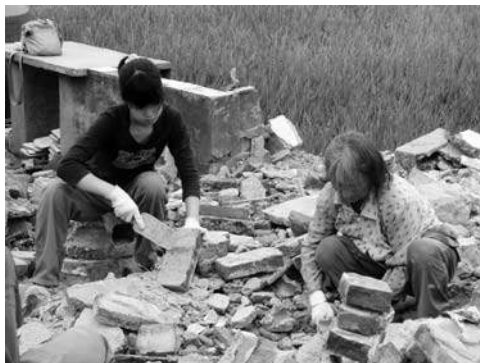
被災者と一緒に煉瓦にくっついたコンクリートを落とす。
