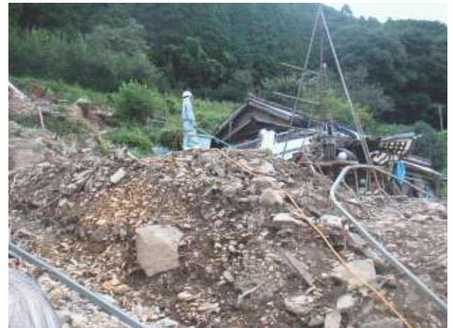
参考写真28 湯出新屋敷地区における復旧工事【d】
