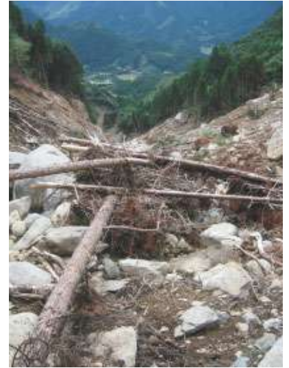
参考写真26 斜面崩落現場から集地区方面 を望む【d】
