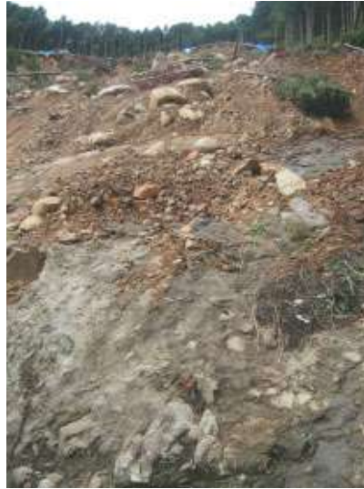
参考写真25 宝川内集地区土石流発生斜面 崩落現場【d】
