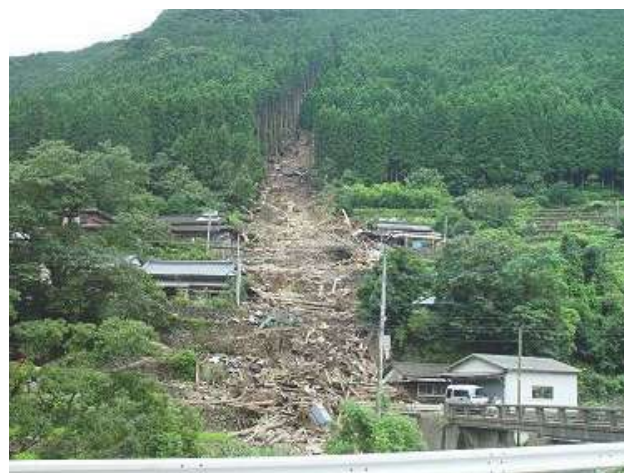
参考写真11 湯出新屋敷地区の被害（7月23日撮影）【d】
