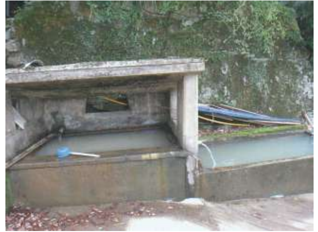
参考写真13 湯出新屋敷地区湧水取水場所【d】
