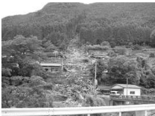
写真2 湯出新屋敷の被害の様子（参考写真11再掲）
