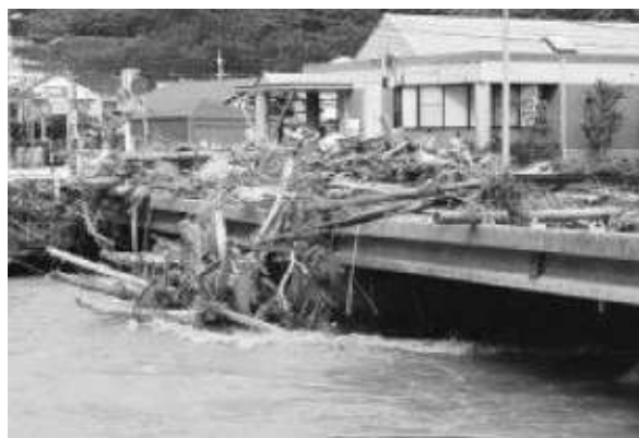
写真3 鶴田橋（参考写真7再掲）
