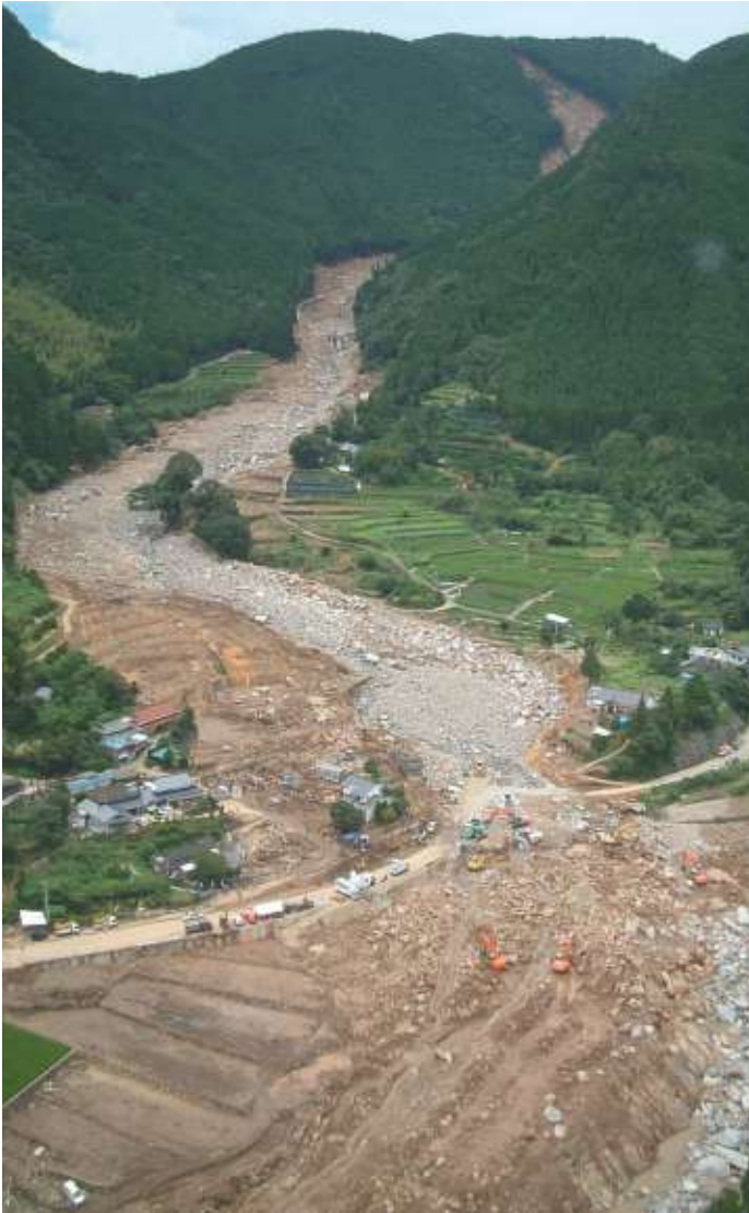
参考写真1 宝川内集地区の被害 (7月22日熊本県防災へりより撮影) 【a】
