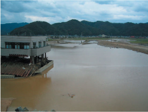
図-10 円山川右岸破堤地点の被災状況
