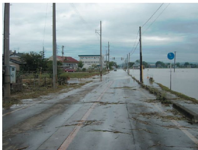
図-4 長岡市福井町の被災状況
