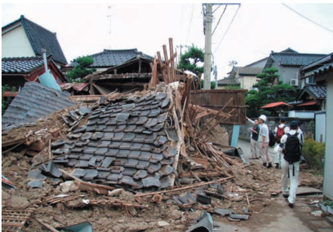
写真5 倒壊した土葺き瓦屋根の家屋
