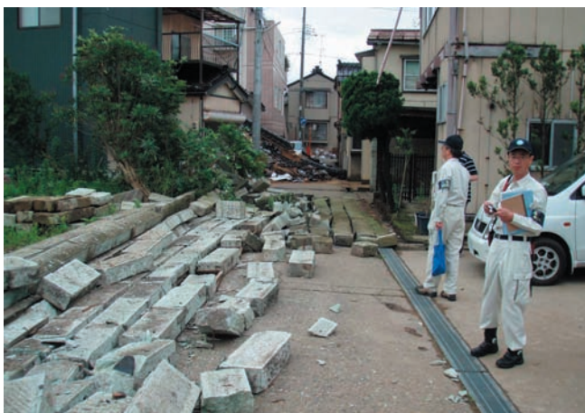
写真7 石塀の倒壊
