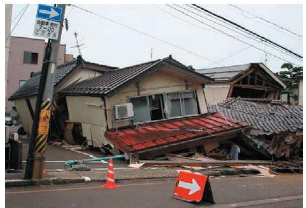
写真4 1階が層破壊した家屋
