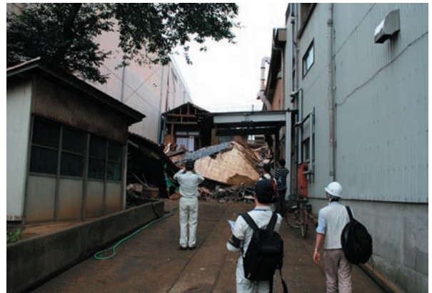
写真3 倒壊した増改築された住家と調査する河田センター長を始めとする研究員
