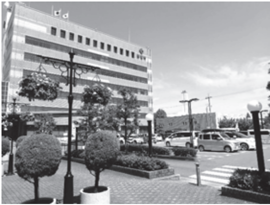
写真 3-28 摂津市役所の外観(06.24 撮影)
