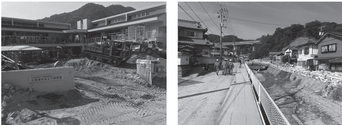
写真 4-23 小屋浦地区の被災状況(07.25 撮影)
