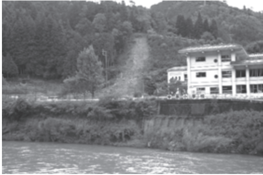
写真 4-34 下呂市焼石の土砂災害現場 (07.12 撮影)
