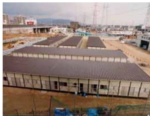
建設された仮設住宅 (兵庫県広報課震災記録写真 (人と防災未来センター所蔵)より)
