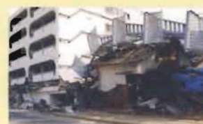
4/2倒壊したマンション（東灘区） 0000420-001285-001.00002
