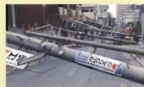
1/17軒並み倒れた電柱（東灘区） 0000420-001009-001.00002
