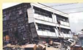
1/26倒壊したマンション（西宮市） 0000420-001086-001.00001
