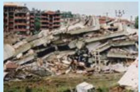
倒壊した中高層住宅
