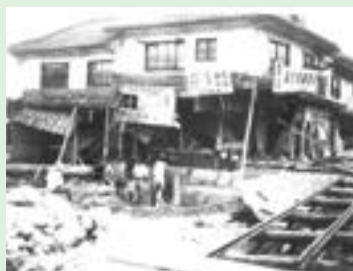
▲宇治川下流域の家屋。水が中を通り、壁を押し流している。
