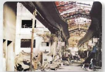
⑤長田の被災状況
