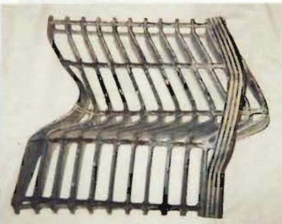
震災によって折れ曲がった側溝の蓋 (2200354-000002)
