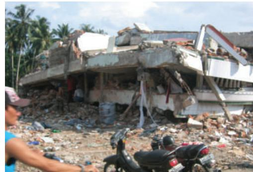
ニアス島での被害の様子、鉄筋コンクリート製の建物の倒壊
