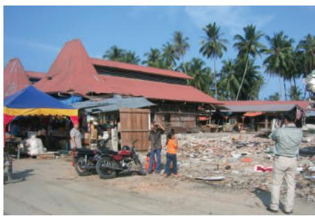
ニアス島での被害の様子、屋根の軽い木造の建物は被害が少ない
