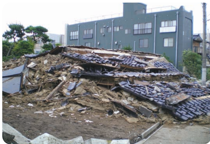
中越沖地震の被災地では、古い家、増築などでバランスが悪くなった家屋が狙われたように倒壊していた(2007年7月17日午後、柏崎市の中心街で)
