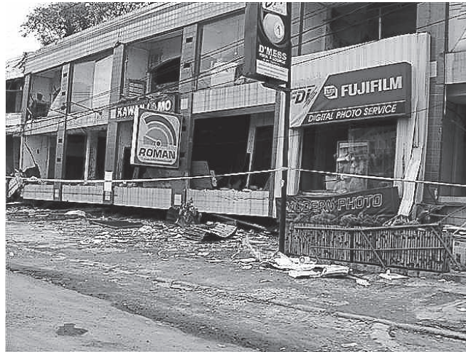
パダン市内で大きく倒壊した RC 建造物
