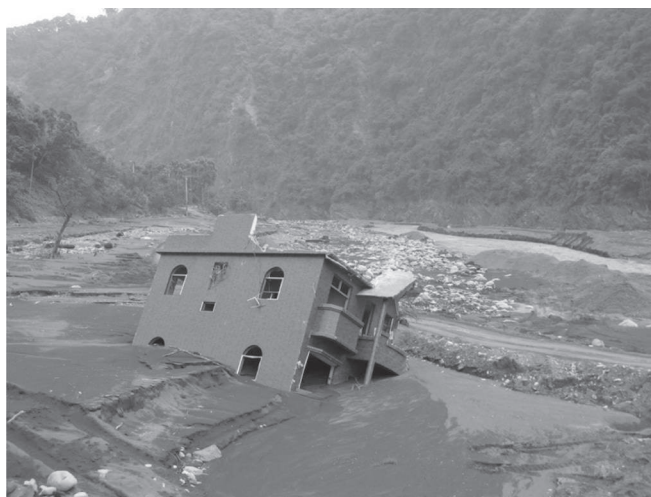
流出した家屋と土砂の堆積 (高雄県茂林郷)
