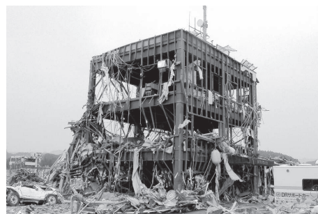
映像の一部（南三陸町防災対策庁舎）
