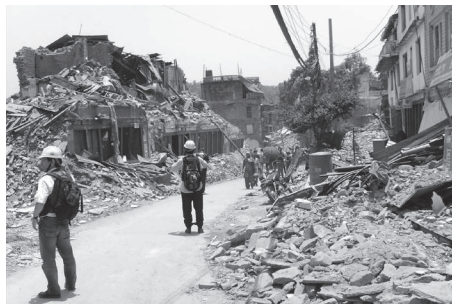
ネパールチャウタラ村被害状況
