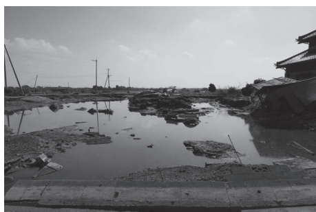
常総市三坂地区<決壊箇所>
