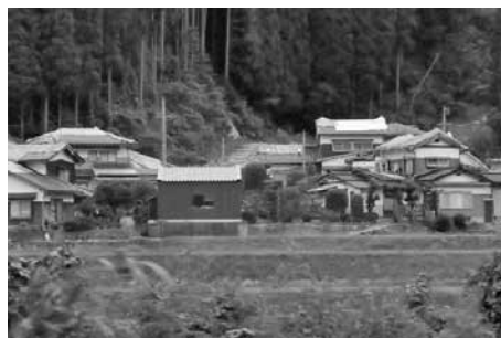
集落の被害状況
