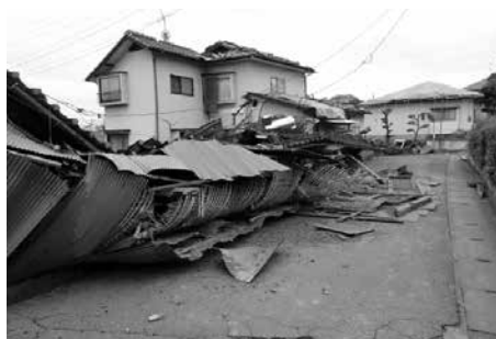
木造建物の倒壊
