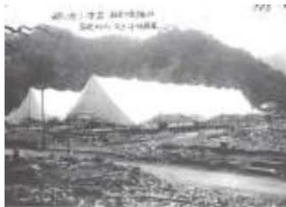
図4 城崎小学校校舎として設置された大テント
