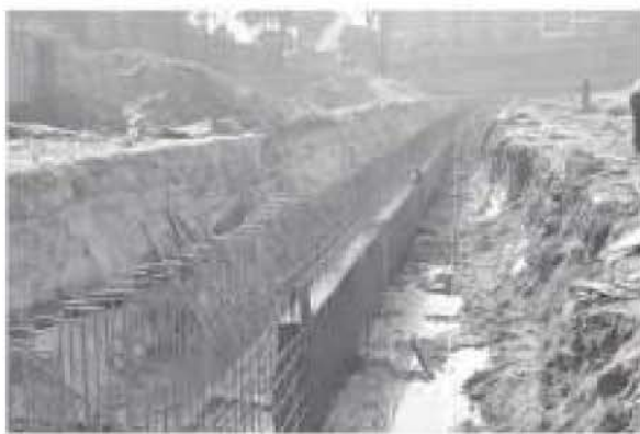
図-2 池の堤防建設における鉄筋コンクリートの使用
