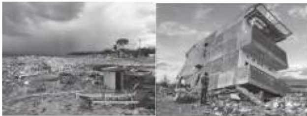
図-3 パルを襲った大地震による液状化後の建物の残骸
