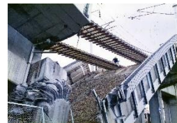
No.6003 新幹線高架復旧作業 西宮市 1995/1/27
