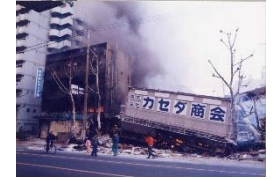
No.5984 火災現場 神戸市長田区 1995/1/17
