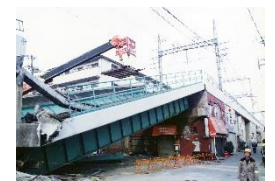
No.5999 路線崩壊 神戸市灘区 1995/1/21
