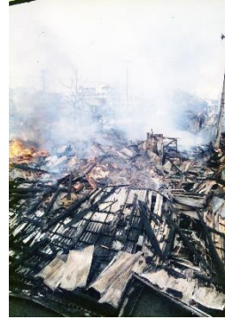
No.5987 火災現場 神戸市須磨区 1995/1/17
