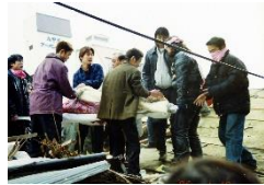
No.6007 生き埋め者の救出 神戸市灘区 1995/1/17
