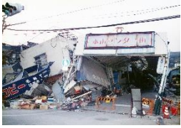
No.5980 商店の被災状況 神戸市東灘区 1995/2/26
