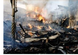
No.5983 火災現場 神戸市灘区 1995/1/17
