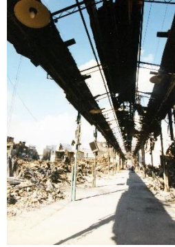
No.5988 火災現場 神戸市長田区 1995/1/27
