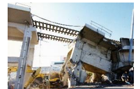
No.6004 新幹線高架復旧作業 神戸市西区 1995/1/27
