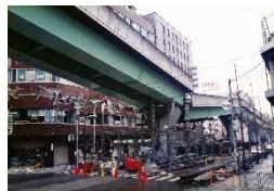
No.6001 ポータルライナー高架崩壊 神戸市中央区 1995/1/23
