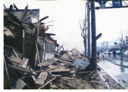
No.5986 火災現場 神戸市須磨区 1995/1/17
