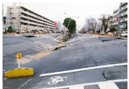
No.6000 道路の陥没 神戸市兵庫区 1995/1/23
