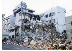
No.5981 病院の被災状況 神戸市東灘区 1995/2/26
