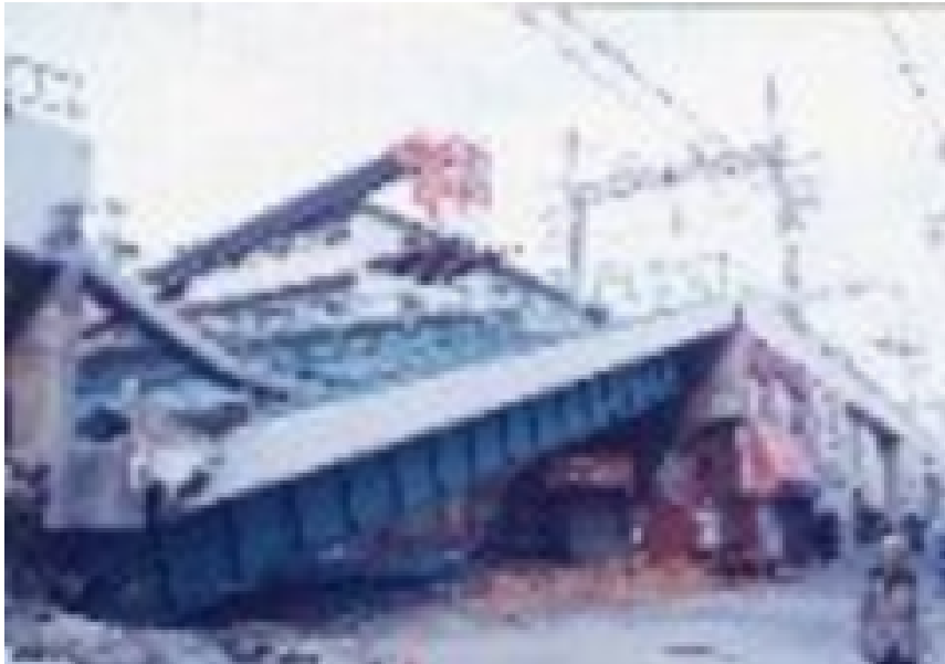
No.5999 路線崩壊 神戸市灘区 1995/1/21
