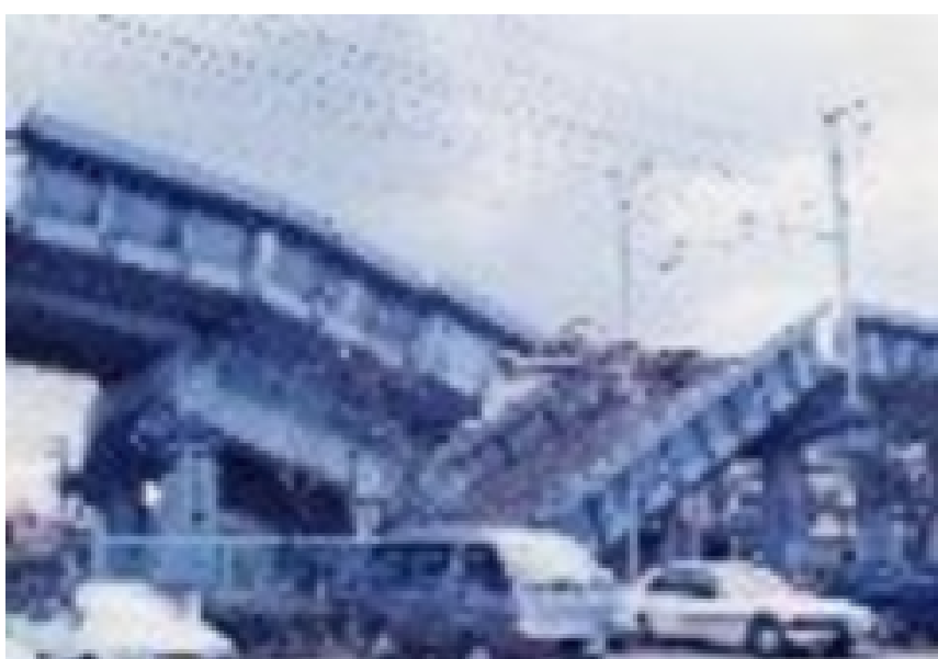
No.6002 新幹線高架崩壊 西宮市 1995/1/24
