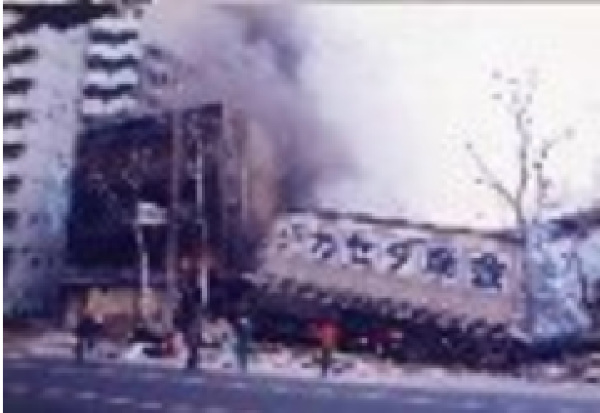
No.5984 火災現場 神戸市長田区 1995/1/17
