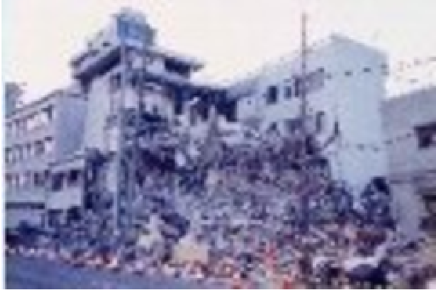
No.5981 病院の被災状況 神戸市東灘区 1995/2/26
