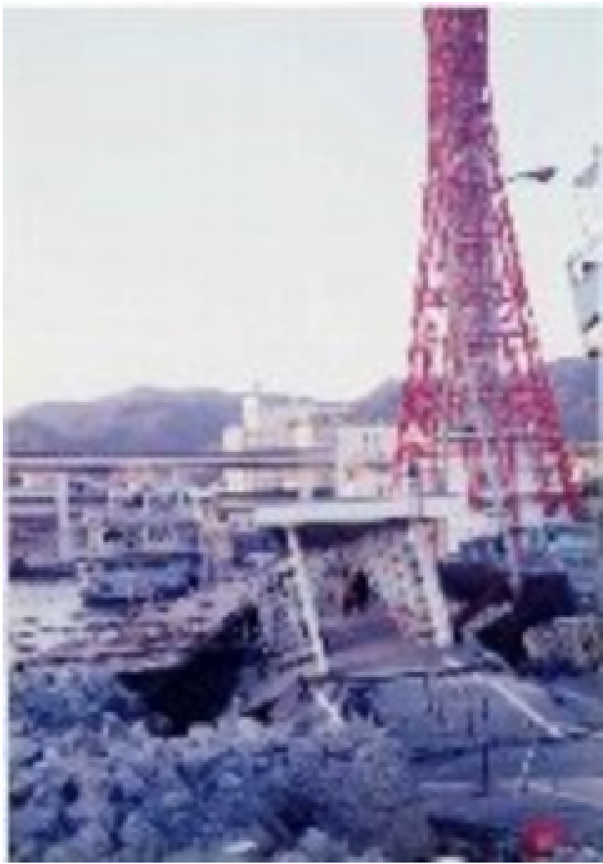
No.6051 港湾の被害 神戸市中央区 1995/2/19
