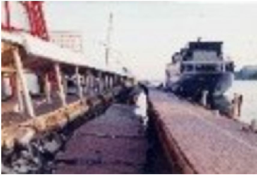
No.6050 港湾の被害 神戸市中央区 1995/2/19
