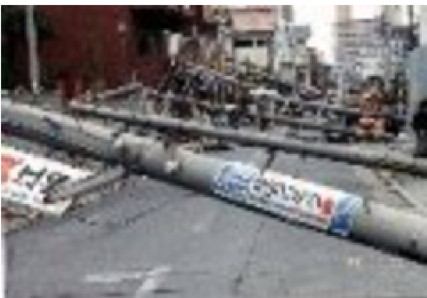
No.6038 軒並み倒れた電柱 神戸市東灘区 1995/1/17
