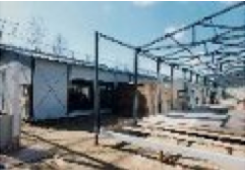
No.6029 仮設住宅建設現場 神戸市兵庫区 1995/1/27
