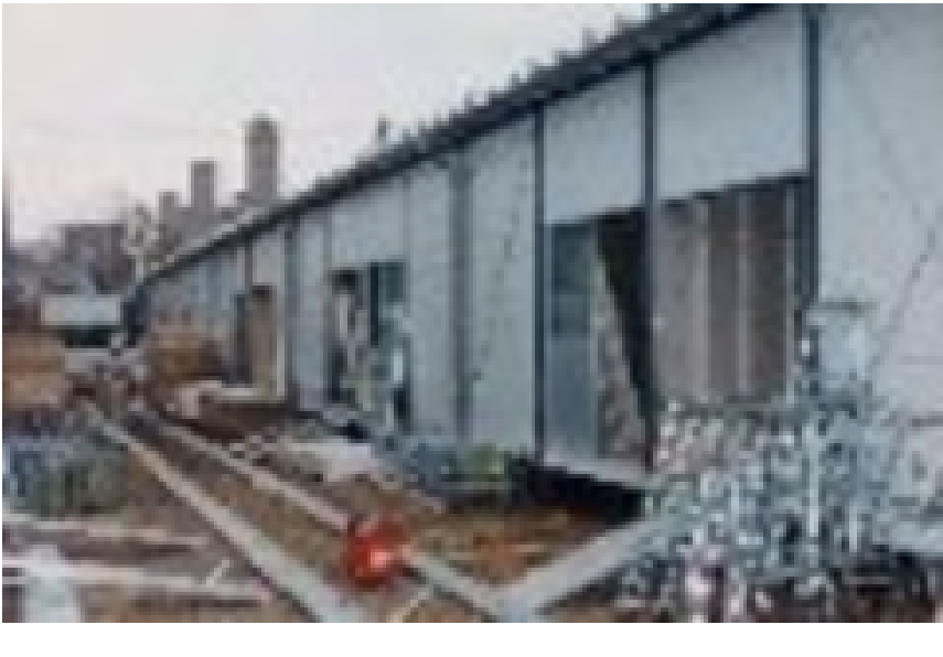
No.6028 仮設住宅建設現場 芦屋市 1995/1/26
