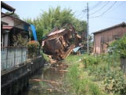
写真13 新郷本町被災状況
