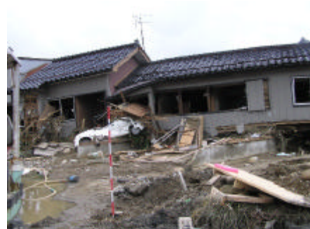
図-4 中之島町妙栄寺付近の被災家屋
