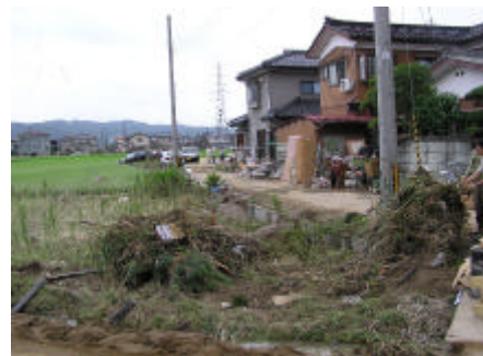
図-1 三条市曲淵地区被害状況
