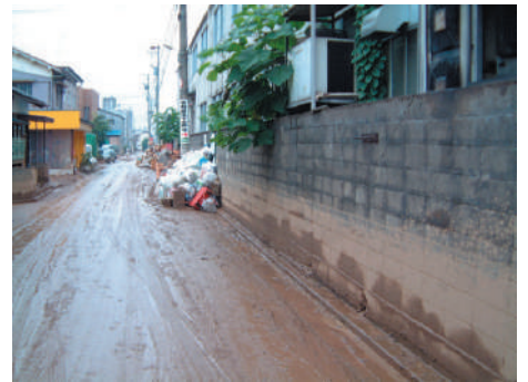
図-15 福井市みのり地区の浸水状況
