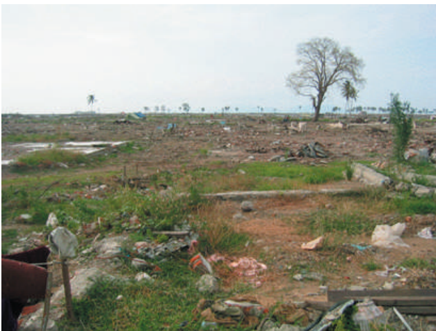
写真4 津浪による広大なツメ跡-1
