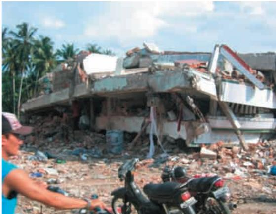
写真2 RC建築の倒壊 (2)
