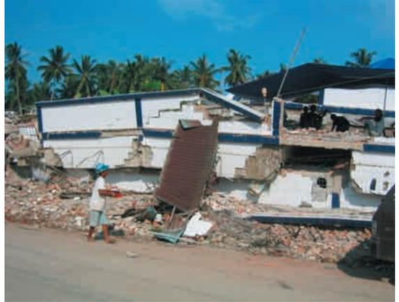
写真3 RC建築の倒壊 (3)
