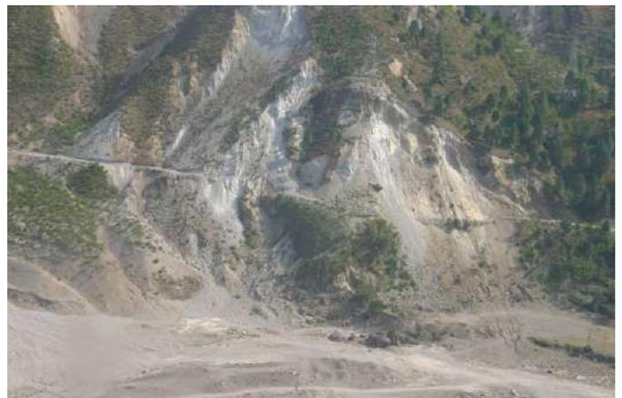
写真19 斜面崩壊による幹線道路の寸断
