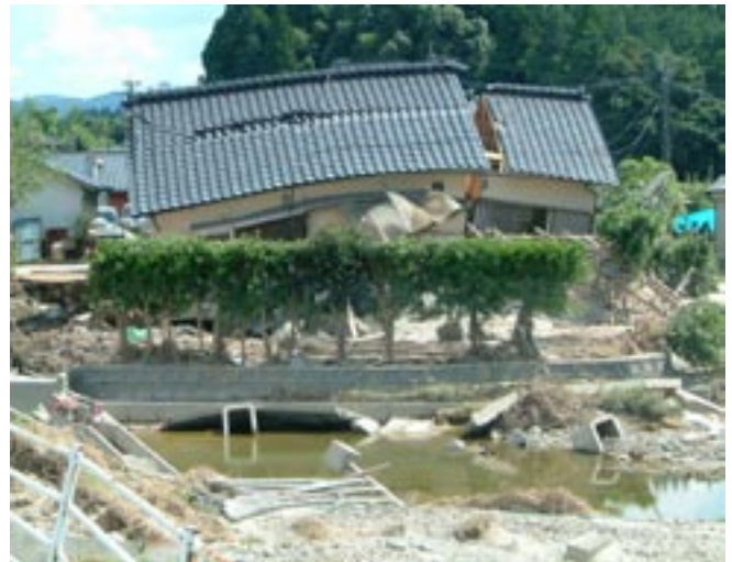
写真5 川内川の氾濫により被災した家屋
