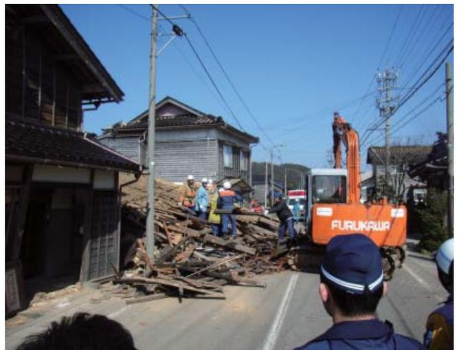
写真3 倒壊した家屋の道路啓開作業
