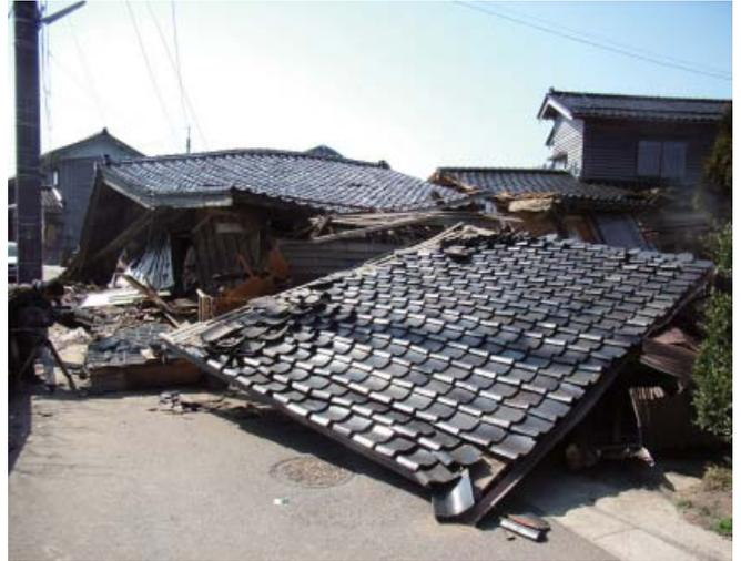
写真2 完全に倒壊した木造家屋
