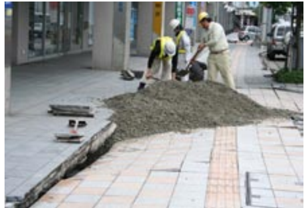
写真 2 道路と建物の間にできた段差
