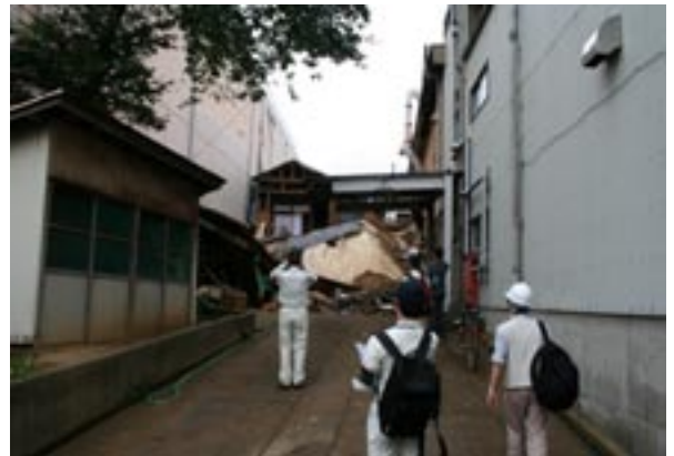
写真 3 倒壊した増改築された住家と調査する河田センター長を始めとする研究員
