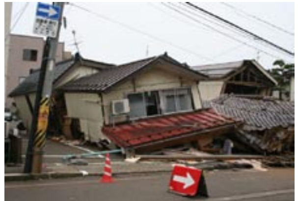
写真 4 1階が層破壊した家屋
