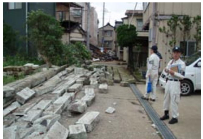
写真7 石塀の倒壊
