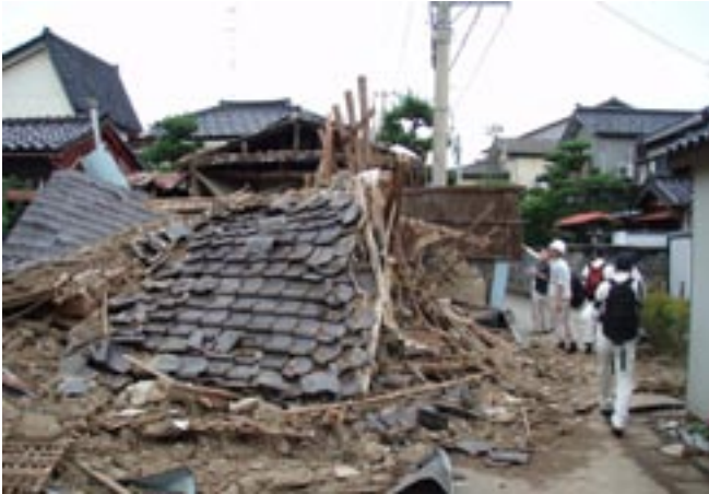
写真5 倒壊した土葺き瓦屋根の家屋
