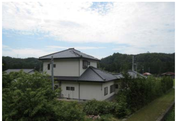
写真2 建物の状況(栗原市花山地区)
