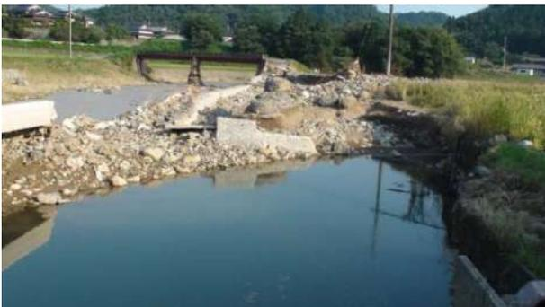
写真2 本郷地区での盛土堤防の被害(左上)
