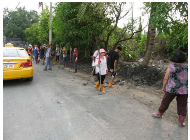
写真9 土砂の除去作業をする臨時雇用された住民
