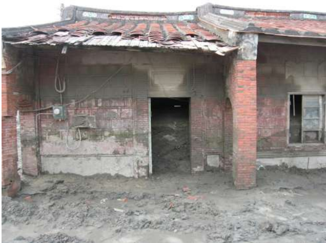
写真8 流れ込んだ土砂によって埋まった家屋
