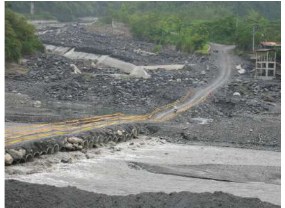
写真2 仮復旧した道路(茂林郷)
