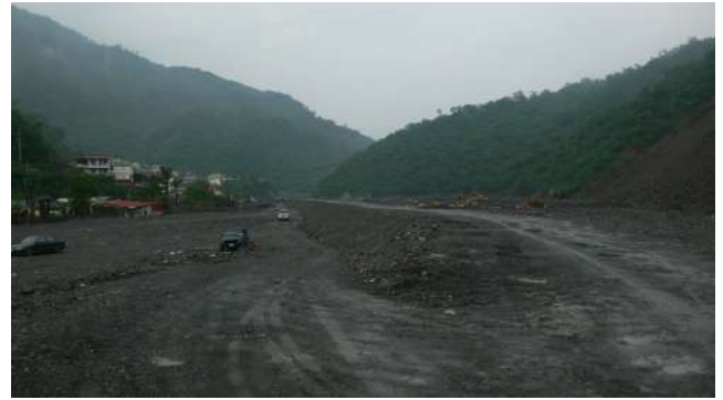
写真5 堆積した土砂と仮復旧の様子(来義郷)
