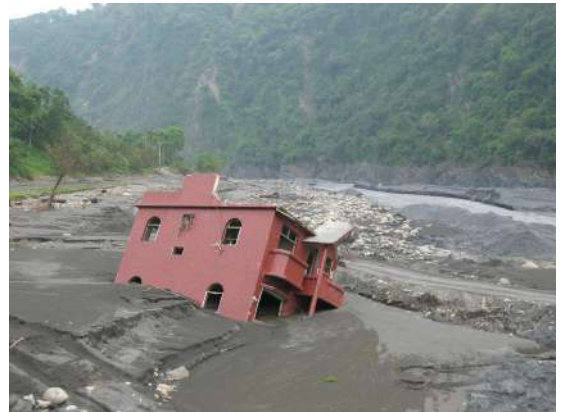
写真3 流出した家屋と土砂の堆積(茂林郷)
