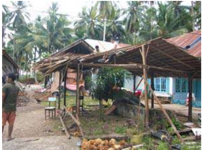
図13 地域協働による仮設避難所の設置作業
