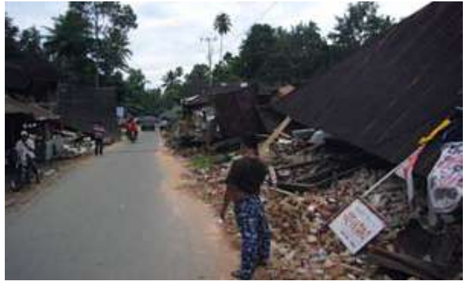
図11 住宅被害の激しい集落の様子
