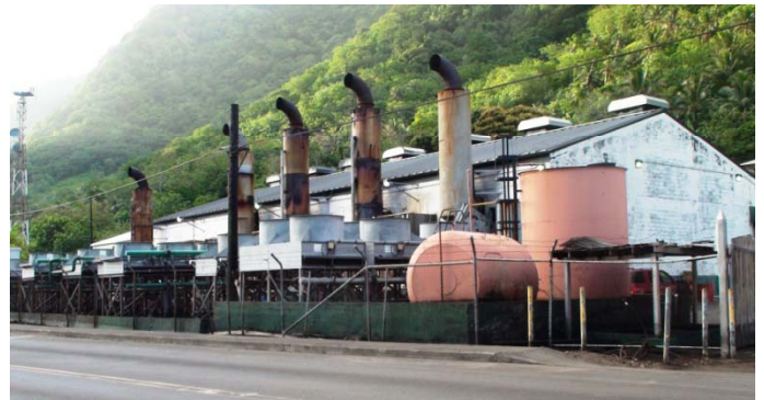
写真8 津波により水没した火力発電所
