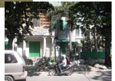
写真2. 中央省庁の建物も倒壊
