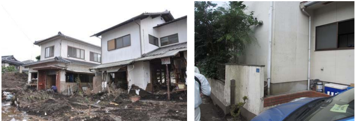
写真1 浸水被害の状況(熊本市龍田陣内地区)
