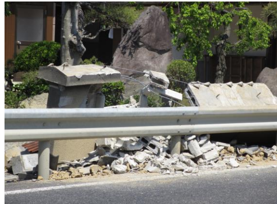
(写真2) 倒壊したブロック壁 (淡路市国道28号線沿い)
