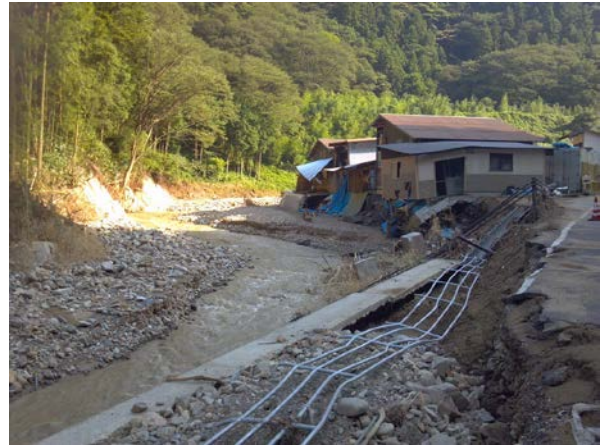
写真4 津和野町高峰牧ヶ野周辺 (河川氾濫により家屋と路面が大破している)
