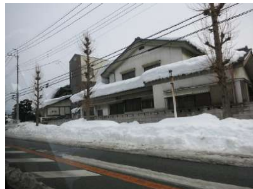
写真7 歩道に残る積雪(甲府市内)
