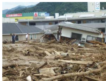
図8 土石流により流出した建築物
