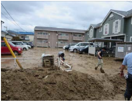
図 10 堆積土砂のかき出し作業
