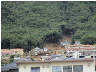
図7 谷の出口で倒壊した建築物
